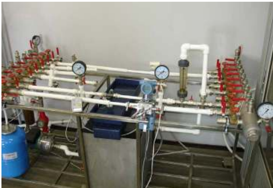
Рис.2.4.3.р.8 Стенд гидравлических испытаний
